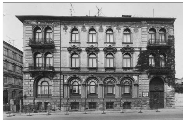
Leipzig, Talstrasse 10: Das 1874 erstellte Verlagsgebäude für den Musikverlag C. F. Peters, heute die Grieg-Begegnungsstätte.
