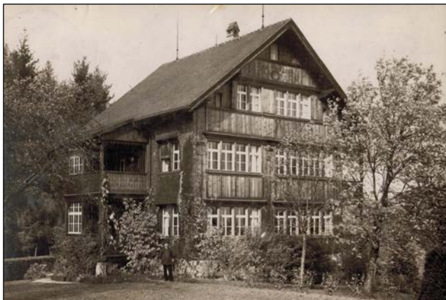
Das Sommerhaus «Abendroth» in Heiden über dem Bodensee, dessen Architekt Herzogenberg war und in das er im Frühling 1892 als Wittwer einziehen musste.
